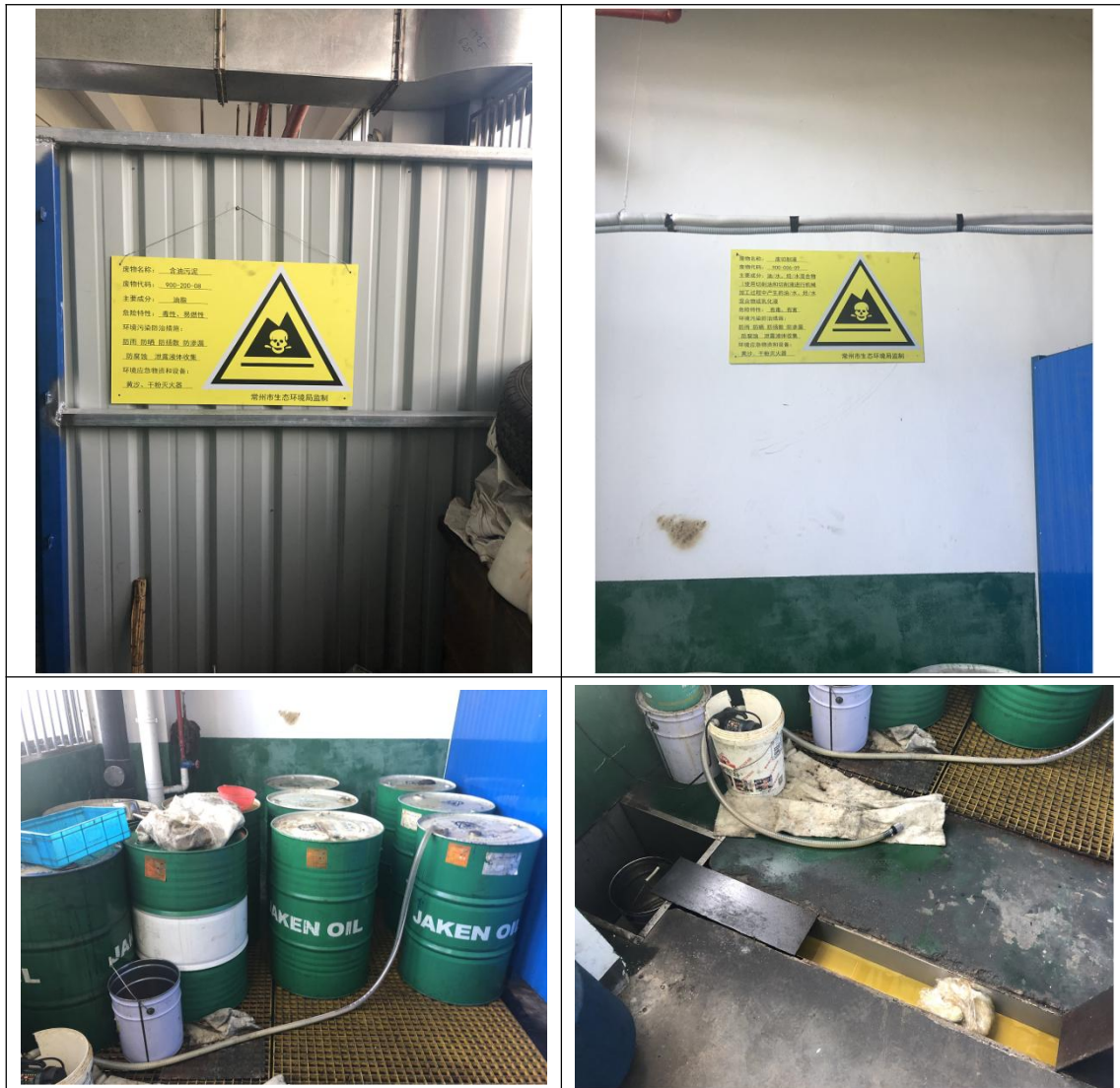
图2-1 危废库建设情况
